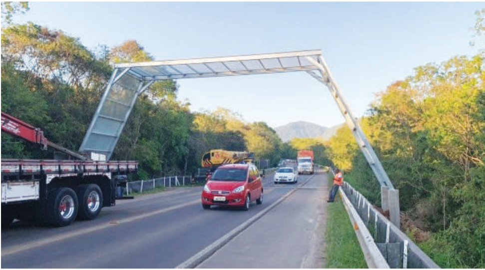
Passagens aéreas e subterrâneas foram instaladas pelo Daer na rodovia para evitar atropelamentos de animais silvestres
