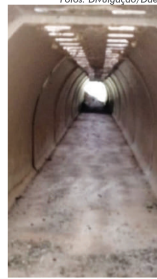
Passagens aéreas e subterrâneas foram instaladas pelo Daer na rodovia para evitar atropelamentos de animais silvestres
